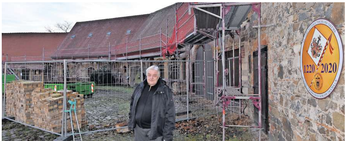
Über den Start der Sanierungsarbeiten an Gebäuden des Rittergutsschlusses Taucha freut sich Jürgen Ullrich, Vorsitzender des Fördervereins. FOTO: OLAF BARTH
