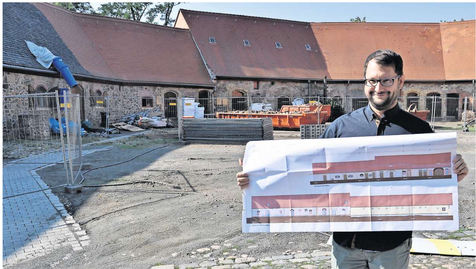
Rathaus-Mitarbeiter Manuel Burke erklärt bei einem Vorort-Termin die künftigen Arbeiten zur Sanierung des Tauchaer Rittergutsschlusses.
